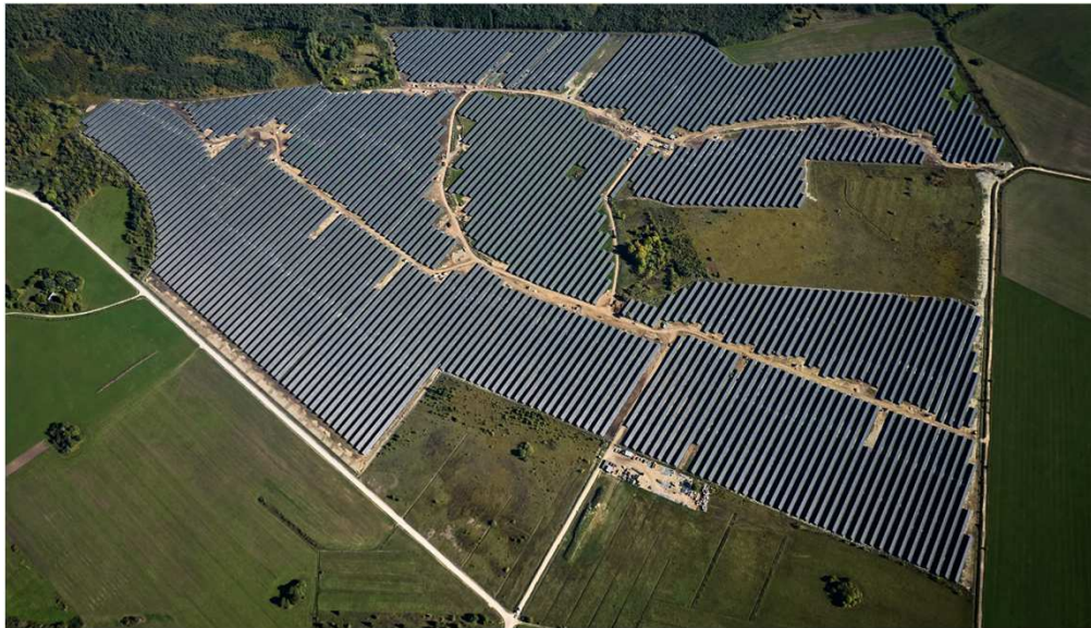
Evecon OÜ Kirikmäe päikesepark 77,53MW
